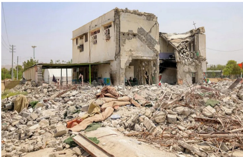
ساختمان نابود شده مدرسه شجره طیه.
